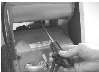
*Le capteur de tirage peut se détruire par une trop forte pression ou dépression (ne jamais aspirer ou souffler avec la bouche dans la sonde coaxiale)*
